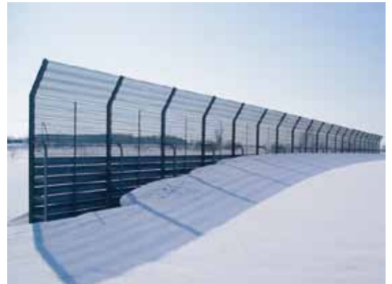
防雪柵(吹き止め柵)
